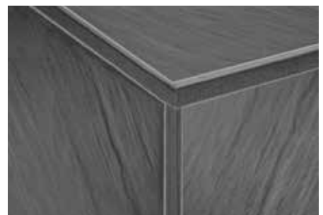
Hoekuitvoering met versteksneede
