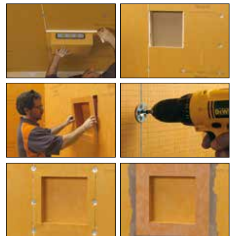
Inbouw in KERDI-BOARD
