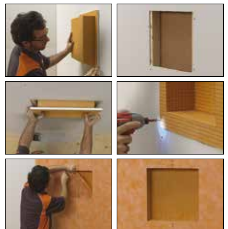
Inbouw in gipsplaat
